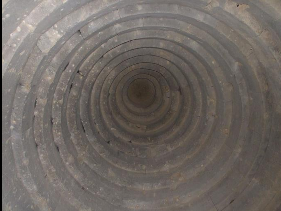
Ступінчасто-кільцева конструкція купола камери, Царський курган, Пантікапей
