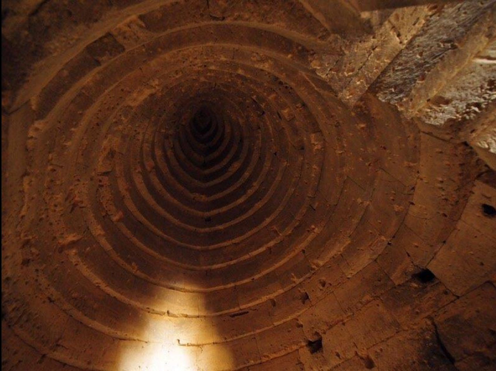
Ступінчасто-кільцева конструкція купола поховальної камери, Царський курган, IV в. до н. е., Пантікапей
