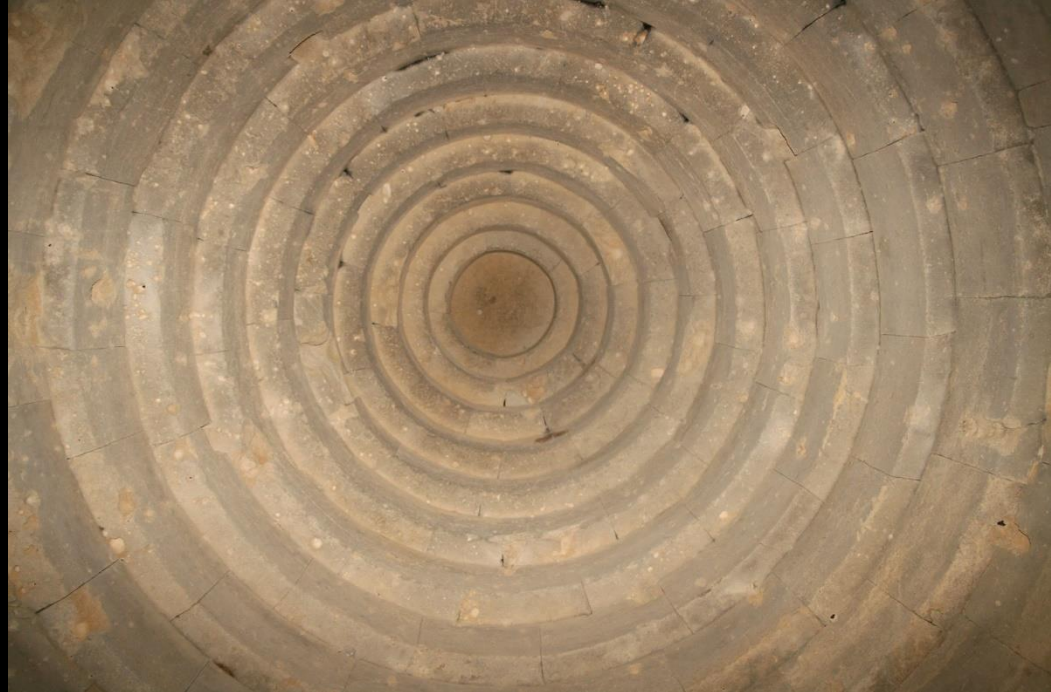
Ступінчасто-кільцева конструкція купола поховальної камери, Царський курган, Пантікапей
