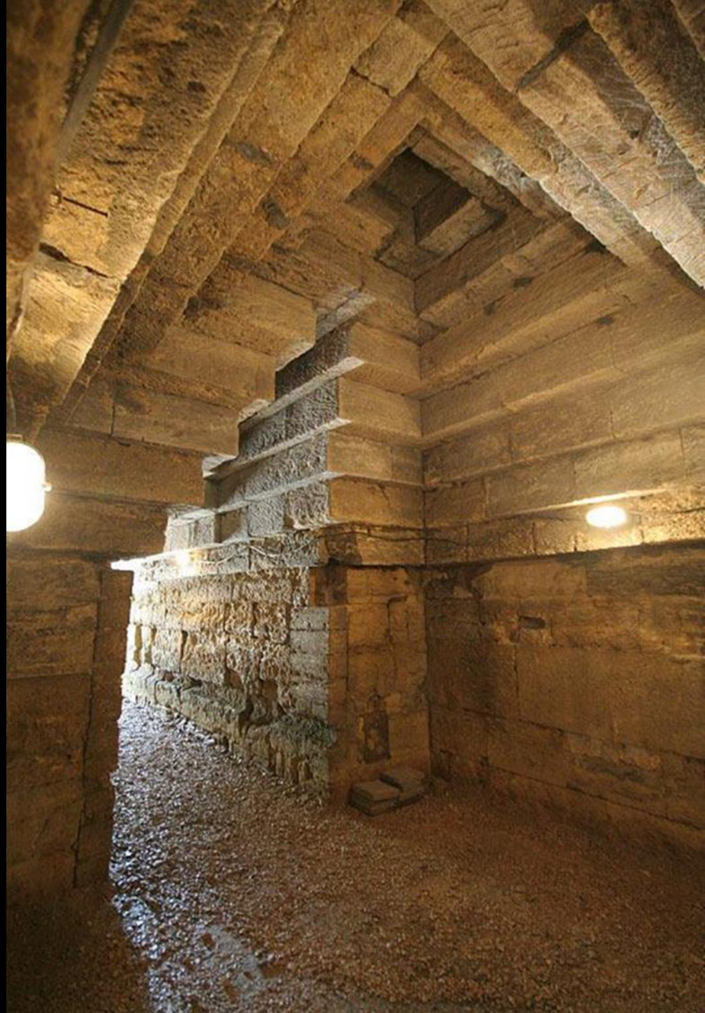
Поховальна камера склепу зі ступінчато-пірамідальним склепінням, Мелек-Чесменський курган, Пантікапей
