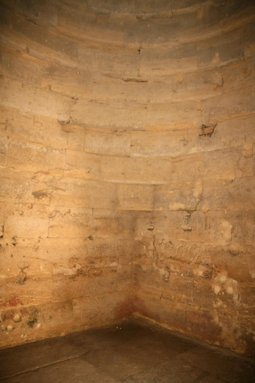
Кут квадратної камери, що переходить в кругле перекриття. Царський курган, Пантікапей
